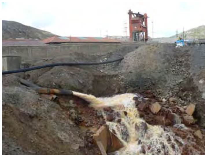
Salida de Agua de Mina de la Empresa Minera Volcan
